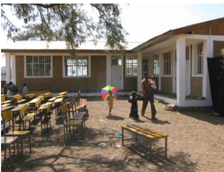
Bibliothek und Unterrichtsräume
